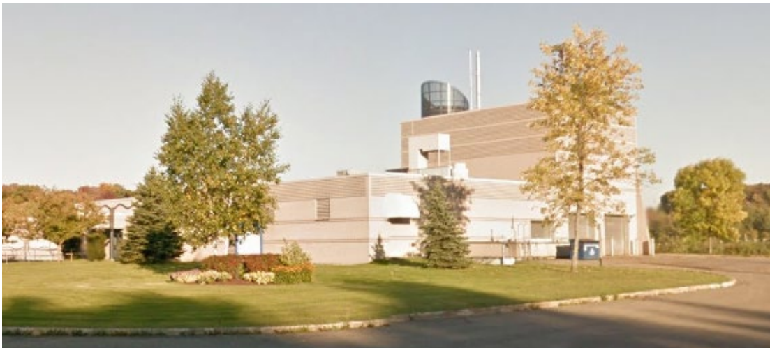
Figure 17 : Station de traitement des eaux usées de Saint-Nicolas
