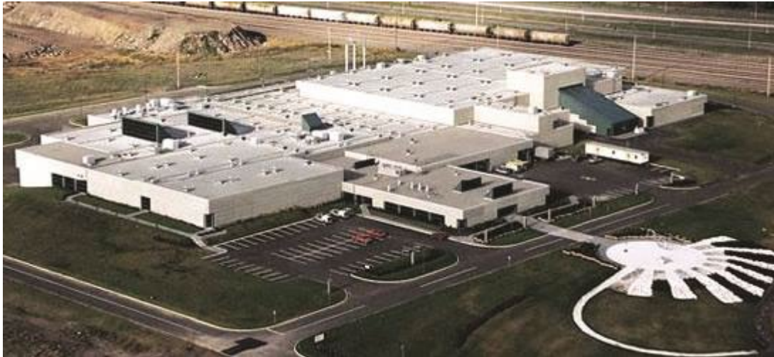
Figure 16 : Station Est de traitement des eaux usées de Québec
